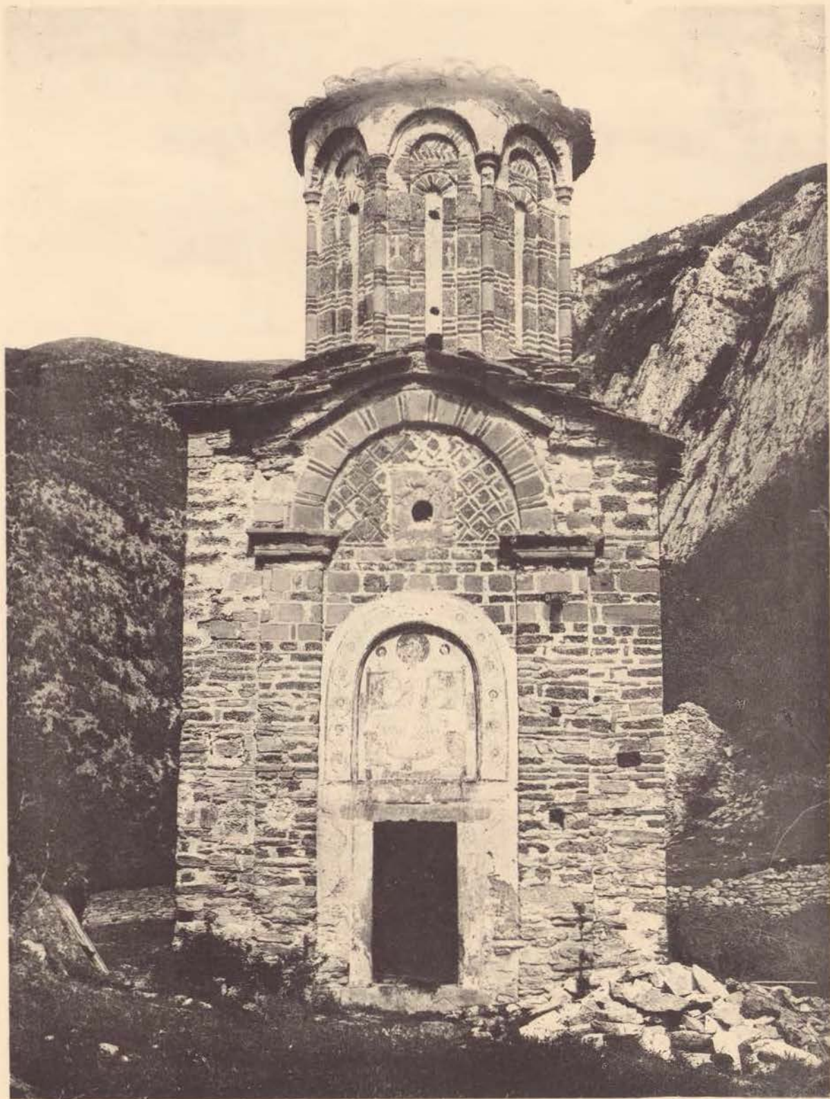
133. Saint-Nicolas, sur la Treska. Façade occidentale.
